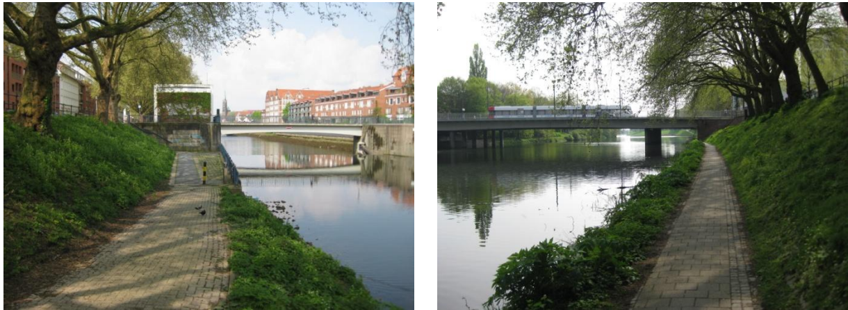
Abbildung 2-5: Deichabschnitt Wehr Kleine Weser bis Wilhelm-Kaisen-Brücke
