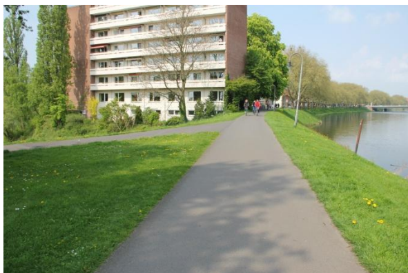
Abbildung 2-7: Deichabschnitt an der Piepe
