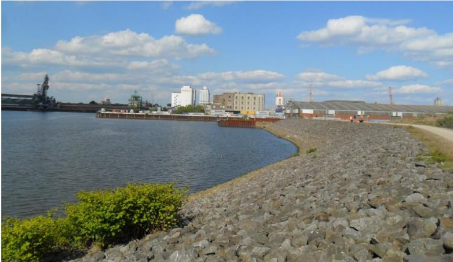
Abbildung 2: Photo der Steinschüttung am Wendebecken
