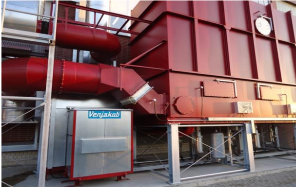
Abb. 26: Drei-Kammer-Wärmetauscher
