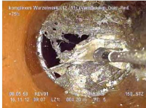
**Defekte Leitung – Schäden durch komplexes Wurzelwerk**
