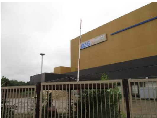
Foto 20 und Foto 21: Standort „Hochregallager“
