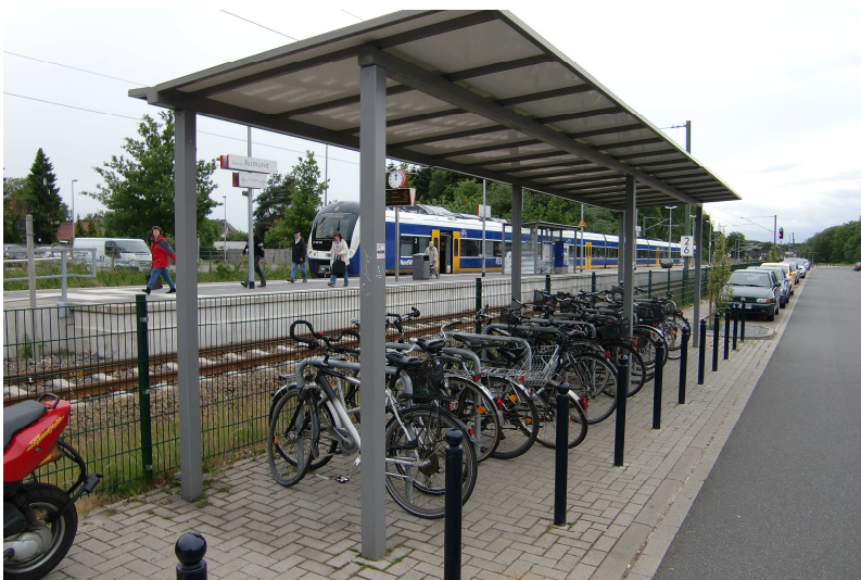
Abbildung 16: B+R-/P+R-Anlage am Bahnhof Aumund [Quelle: Agentur BahnStadt]
