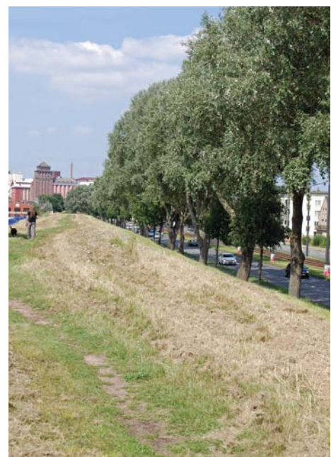
Deich an der Nordstraße, stadtauswärts (ehem. Zollbinnenlinie)
