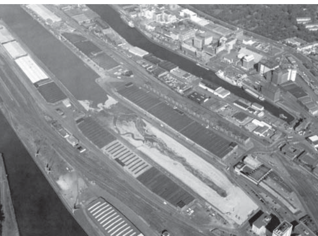
Der verfüllte Hafenkopf vor Schuppen 13 und 14, 1998/99 (Quelle: Der Bremer Überseehafen, Edition Temmen 1999)
