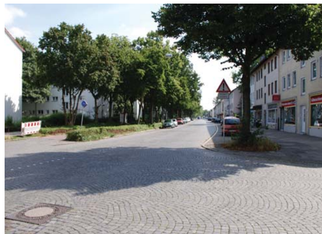
Steffensweg, Höhe Grenzstraße, stadteinwärts
