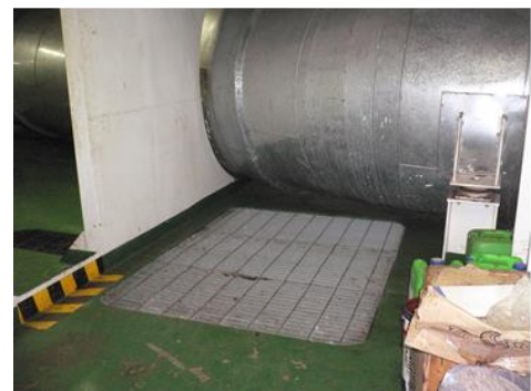
Abb. 9: Maschinenraum und Schott
