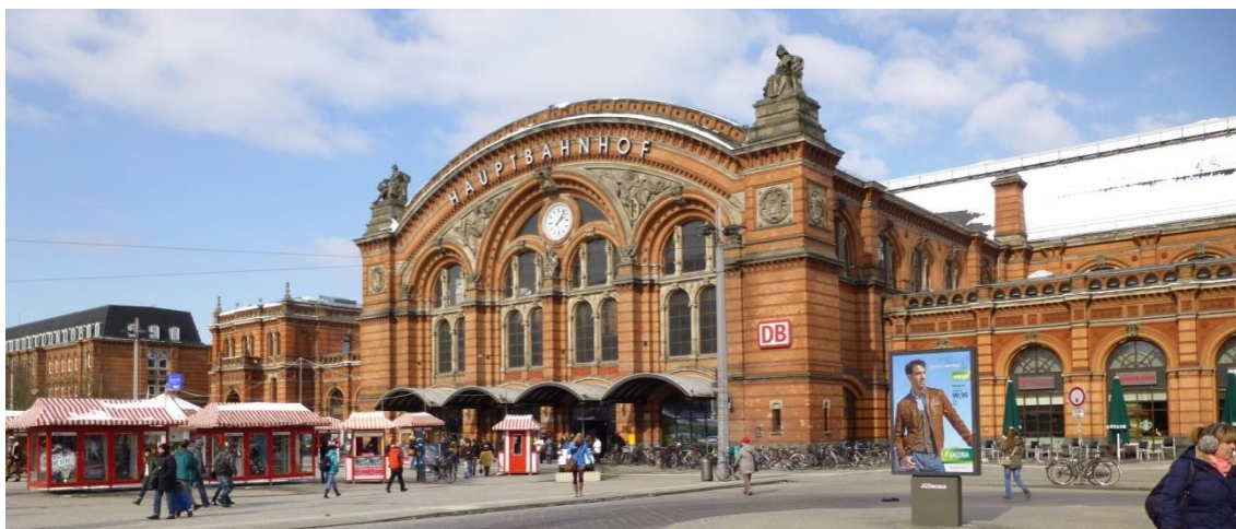
Abbildung 171: Der Bremer Hauptbahnhof mit seinem imposanten Eingangsportal
