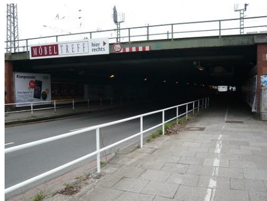
Findorfftunnel (Mitte, Findorff)
