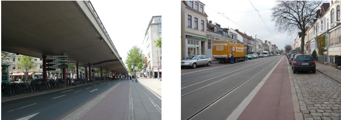
Abbildung 59: Hochstraße am Breitenweg als Beispiel für die städtebaulich negative Wirkung von Verkehrsstraßen und dem gegenüber die Hamburger Straße als Beispiel für die Ausbauphilosophie der gemeinsamen Nutzung des Straßenraumes durch die verschiedenen Nutzer/innen
