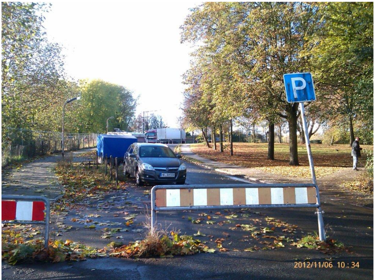
Foto: Blick in die Grünanlage (heute noch Straße)
