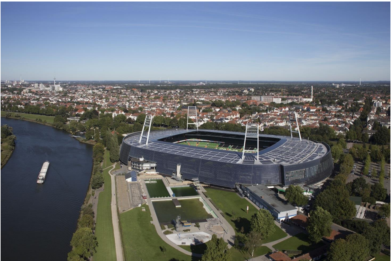
Foto: Bremer Weserstadion / PV-Anlage
