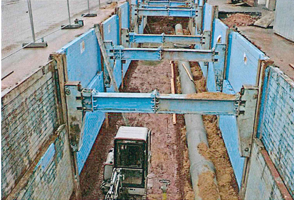
↳ Gestufter Linearverbau mit U-Laufwagen
