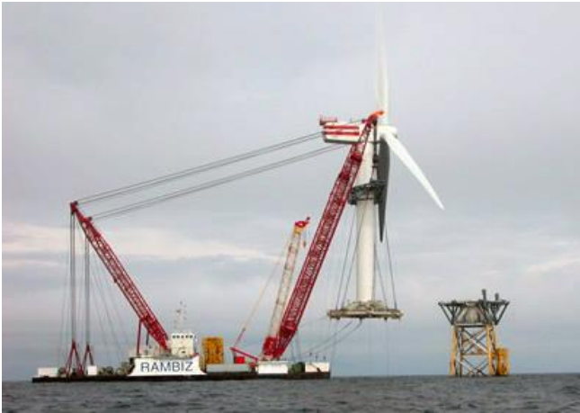
Abb. 3.1.6.: Installation komplett montierter Anlagen Schwimmkran Rambiz 4000 to Tragkraft, Breite 44 m, Länge 88 m mit Repower 5 M – komplett montiert
