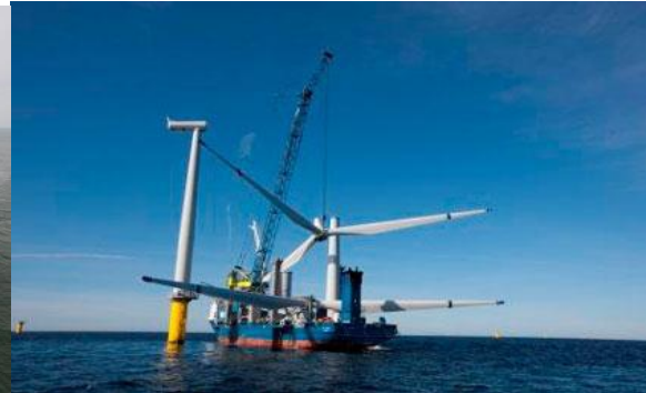
Abb. 3.1.6.: Installation komplett montierter Anlagen Schwimmkran Rambiz 4000 to Tragkraft, Breite 44 m, Länge 88 m mit Repower 5 M – komplett montiert
