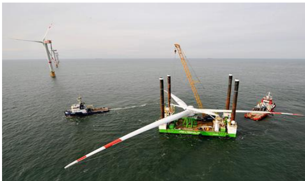
Abb. 3.1.7.: Rotorstern an Land vormontiert und Installation auf See
