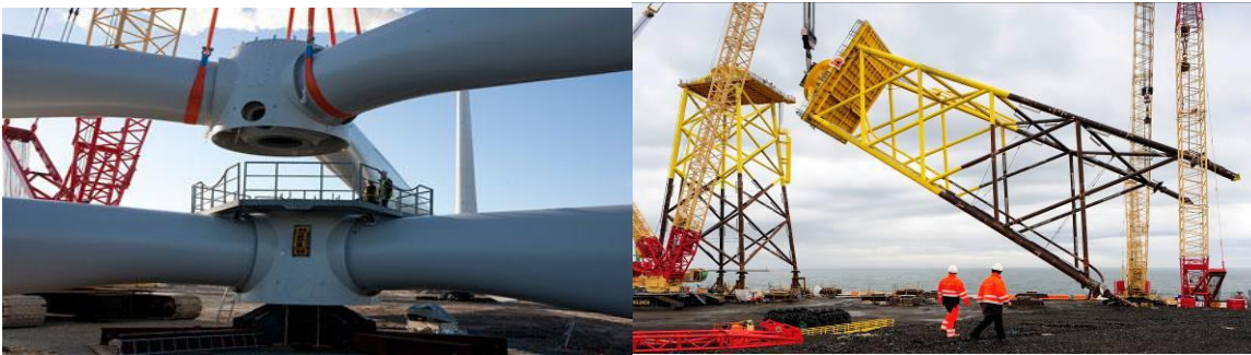
Abb. 3.2.1.2 Flächenfunktionen: Zwischenlager Rotorstern, Aufrichten Jacket Gründungsstruktur vor der Verladung
