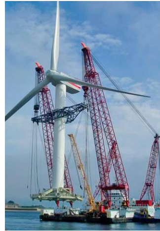
Abb. 3.1.6.: Installation komplett montierter Anlagen Schwimmkran Rambiz 4000 to Tragkraft, Breite 44 m, Länge 88 m mit Repower 5 M – komplett montiert
