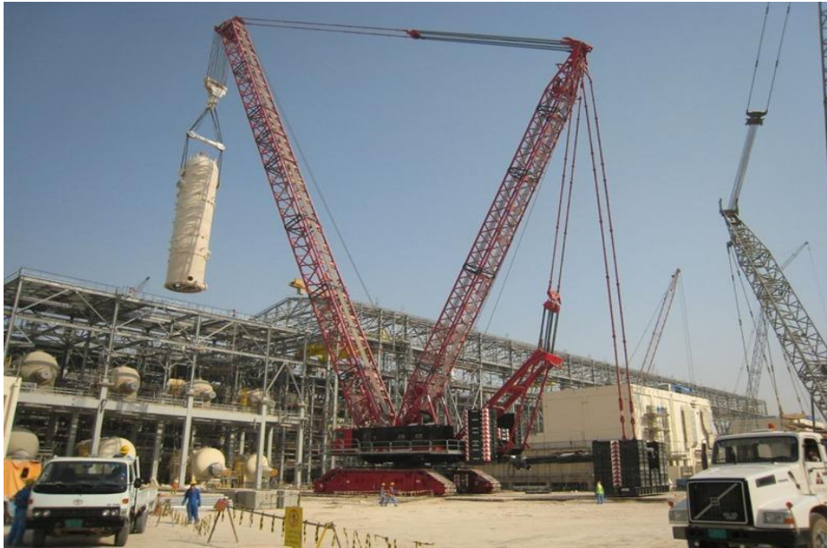
Abb. 3.2.2.2: Große Raupenkran beanspruchen auf der Kaikante einen erhebliche Arbeitsbereich von bis zu 50m
