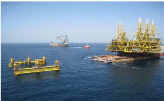
Abb. 3.1.3: Konventionelle Errichtung von Plattformen
