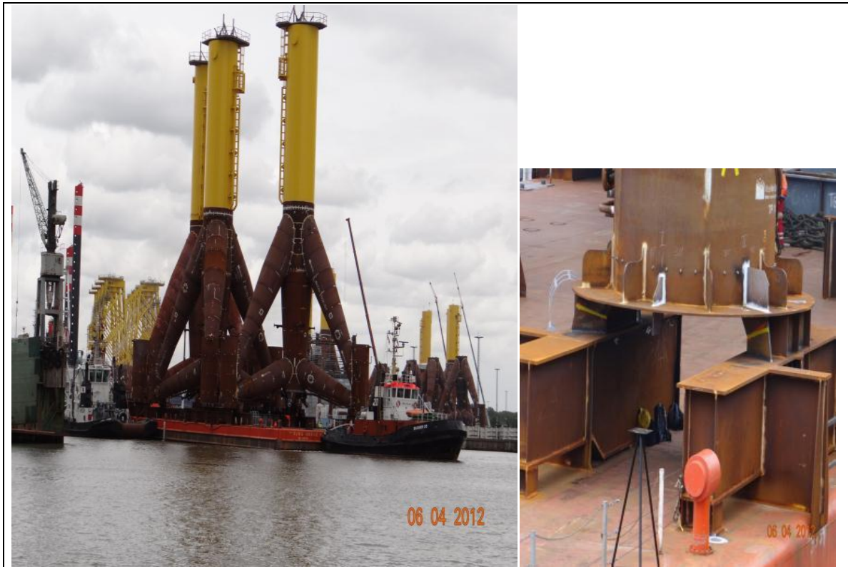
Abbildung 27: Transport von Tripod-Gründungskörpern mit Standard Transportequipment
