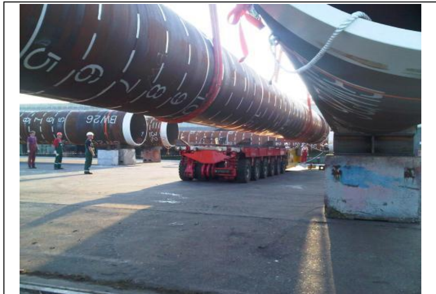
Abbildung 9: Ein sog. Rammpfahl – Verladung und Vorstau an der Kaikante
