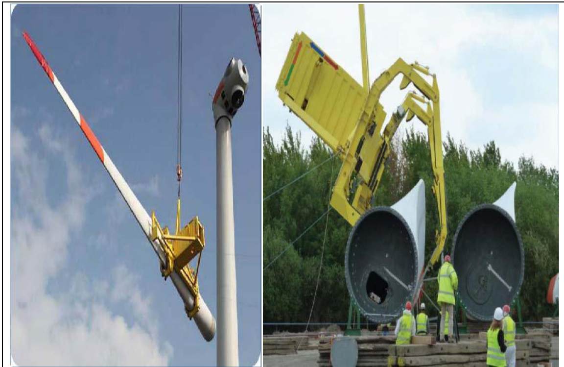
Abbildung 15: Einzelblattmontage – Test an Land – sog. Blade Dragon
