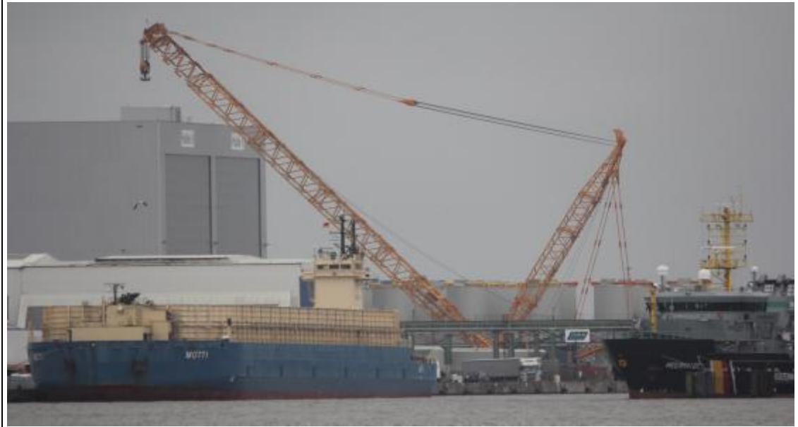
Abbildung 29: Einfahrt in den Labradorhafen, Blick aus Richtung der Schleuse in den Süden, keine Begegnungsverkehre möglich
