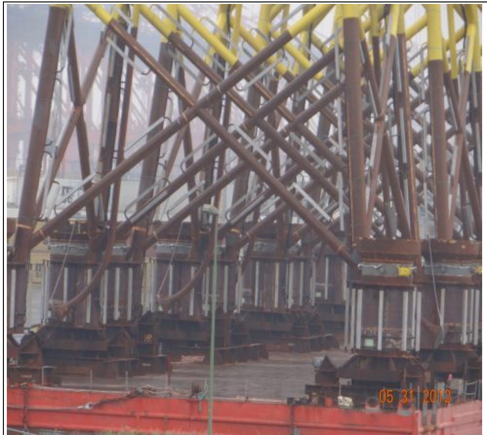
Abbildung 16: Zwischenlagerung von Jacket-Gründungskörpern auf Ponton
