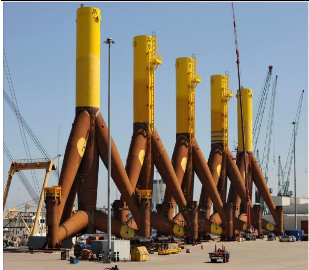
Abbildung 7: Bereitstellung von Gründungskörpern für die Verladung an der Kaikante
