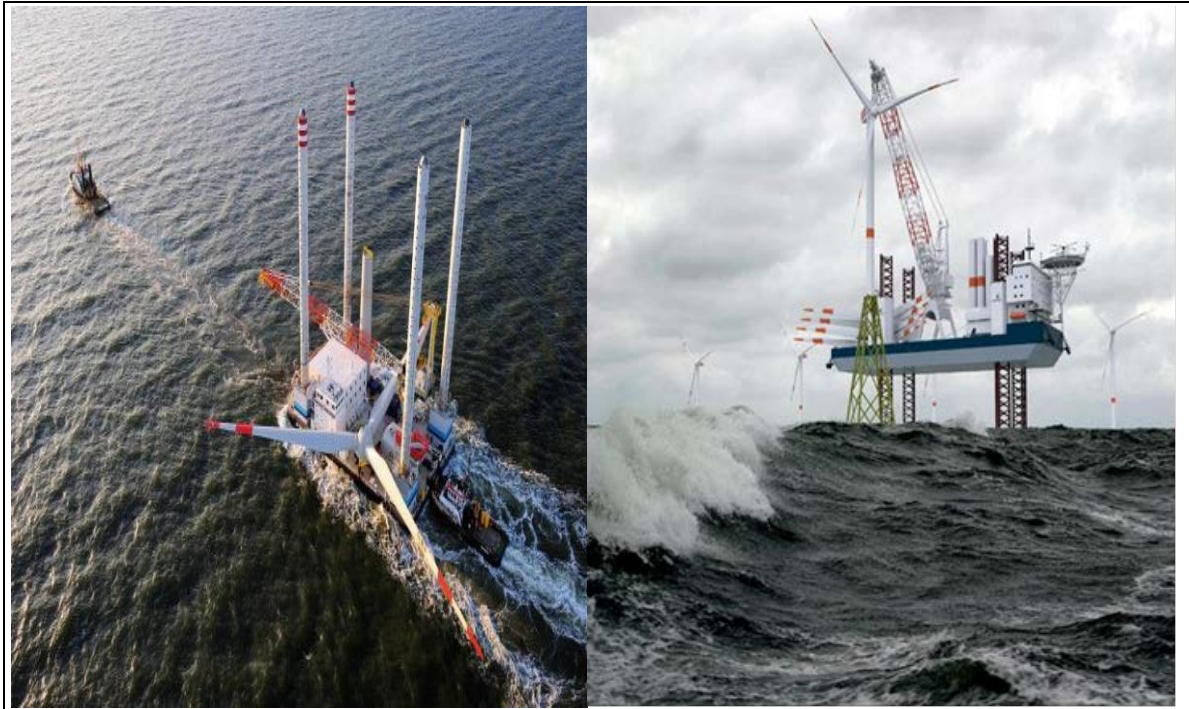
Abbildung 17: Transport und Installationsmethoden auf See, hier Rotorstern
