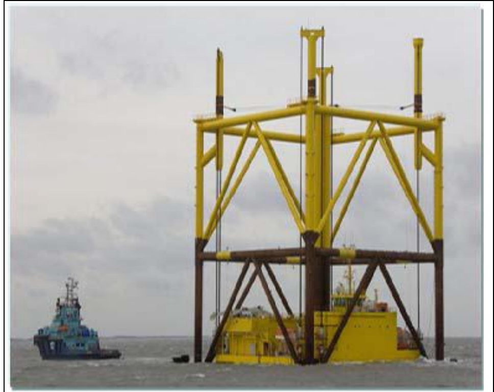
Abbildung 5 Transportverfahren Topside Bard Offshore 1 im Jahr 2009. (Abmessungen 30 x 30 Meter, Tiefgang 6 Meter)
