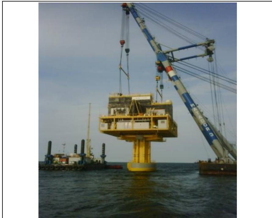
Abbildung 2: Installation der Topside Baltic 1 mit einem Schwimmkran
