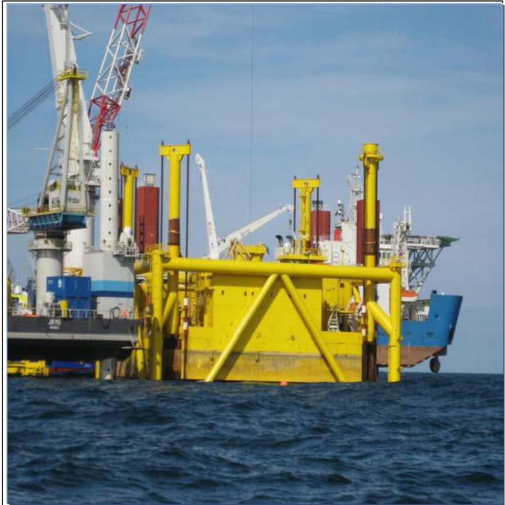
Abbildung 6: Zwei Jackup-Schiffe bei der Installation einer Trafoplattform
