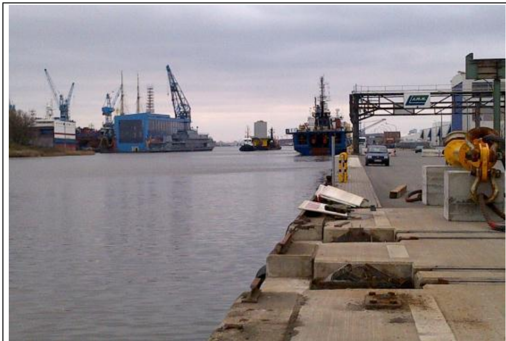
Abbildung 30: Einfahrt in den Labradorhafen, Blick in Richtung der Fischereihafenschleuse in den Norden, keine Begegnungsverkehre möglich
