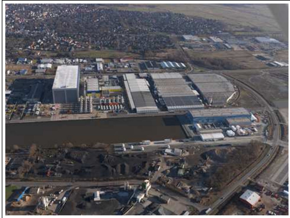
Abbildung 14: Der Labradorhafen mit den Schwerlastplatten und Fertigungsstätten von Weserwind, Areva Wind, Repower sowie dem Holzhandel von Coordes
