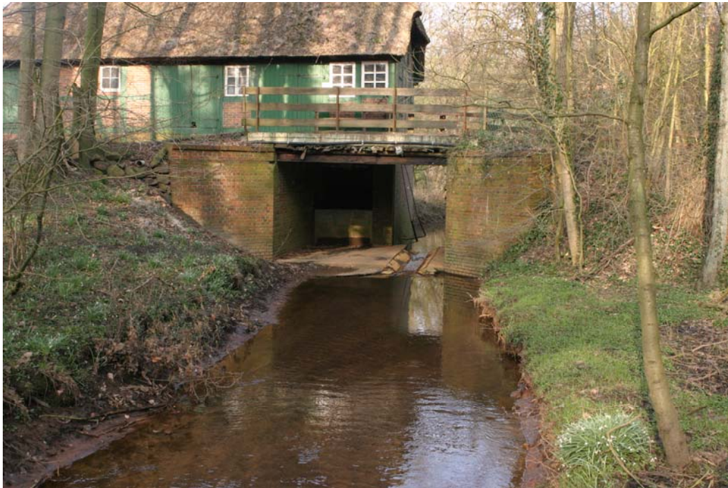
Foto 1: Mühlenensemble von oberhalb gesehen
