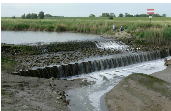
Foto 5: Überlaufschwelle A zum Treuenfelder Arm – langer WQasserablauf in der Niedrigwasserphase
