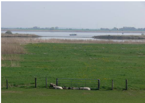
Foto 1: Blick vom Deich auf das Flachgewässer mit Überlaufschwelle
