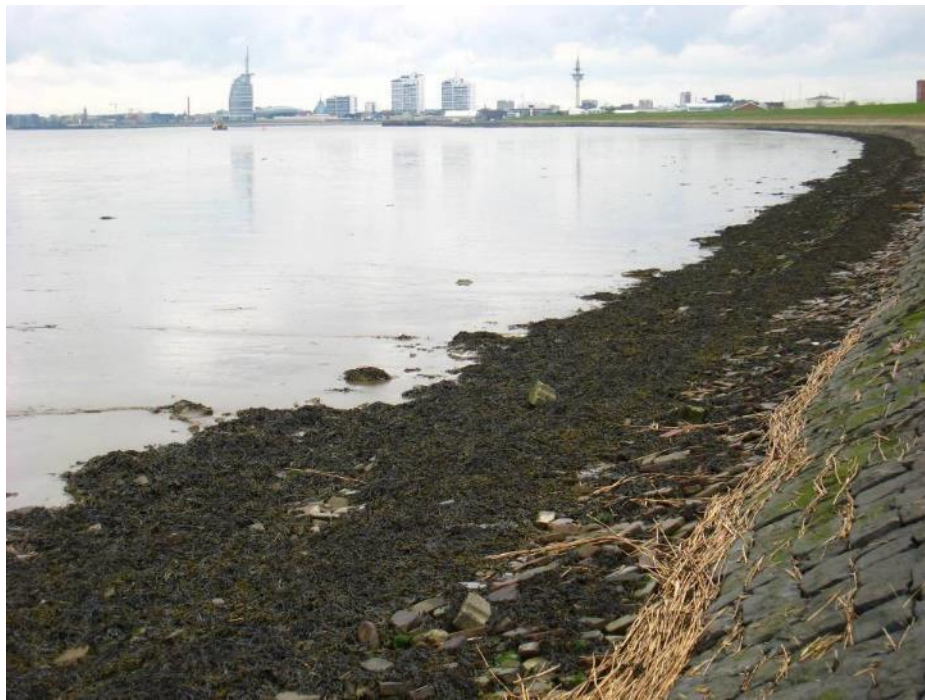
Abb. 16: Blasentang-Bewuchs am Fuß des Deckwerks am Deichfuß im Vorhabenbereich
