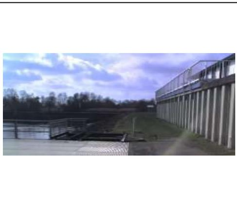
Die Hochwasserschutzlinie im Plangebiet ist durch eine im Abstand von 3,50 m bis 13,50 m hinter dem Böschungskopf angeordnete Hochwasserschutzwand festgelegt (s. Unterlage 2.2 *Lageplan*). Über Deichschar te ist der Hafen von der Landseite aus zu erreichen. Die der Böschung nachgeordnete Rasenfläche ist dem Deichvorland zugeordnet.
