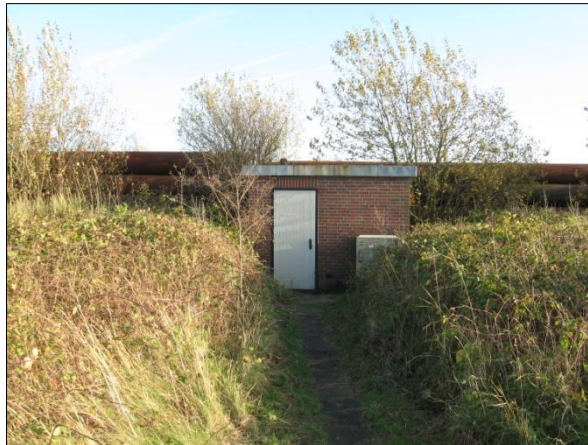
Abbildung 6: Übergabe- und Messstation
