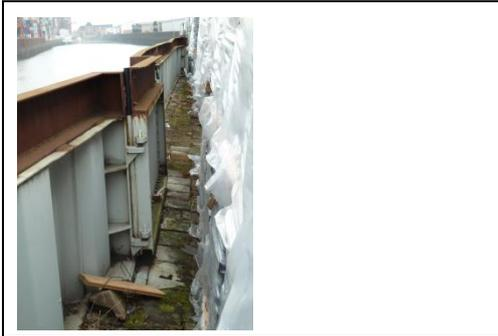
Zwischen Station 92.90 und 99.00 sind Tore für die Kantenpoller in der HWS-Wand angeordnet, die auf der Oberkante der Uferbefestigung liegen (s. nebenstehende Abbildung). Die Tore werden im Bedarfsfall bei Belegung der Poller geöffnet.
