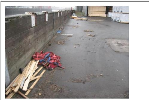
Zwischen den Stationen 102.80 - 114.30 und 118.80 - 125.00 ist die HWS-Wand auf einer Länge von insgesamt rd. 100 m als Gießständerkonstruktion mit Dammbalkentafeln ausgebildet (s. nebenstehende Abbildung). Die Dammtafeln aus Holz sind dauerhaft eingesetzt und werden ausschließlich für die Dauer von Schiffsbe- und -entladevorgängen gezogen.
