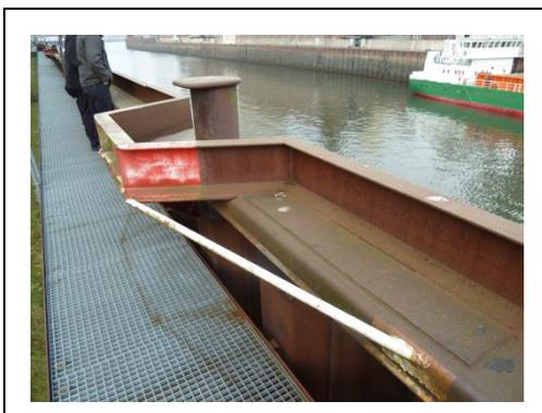
Die angrenzenden Flächen werden gewerblich genutzt. Mit Unterbrechungen im Bereich zwischen Stat. 32,0 bis 45,0 und zwischen Stat. 68,0 bis 90,0 bestehen ufernah Lagerschuppen. Die Höhenlage der Spundwände liegt z. T. bis zu 1,7 m über dem anstehenden Gelände. Der Leinenpfad ist in diesen Teilbereichen als Laufsteg in Stahlbauweise mit Gitterrosten ausgebildet.
