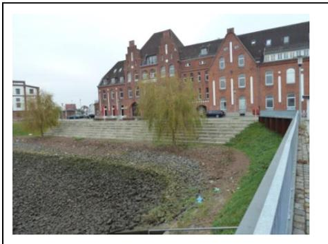
Vor Kopf des Hafens ist von NHN +4,30 m bis NHN +7,47 m eine Treppenanlage mit Sitzstufen, Baujahr 2009/2010, in die Böschung integriert (s. nebenstehende Abbildung). Die Stufenanlage ist flach gegründet und die Stufenelemente wurden als Stahlbetonfertigteile ausgeführt.
