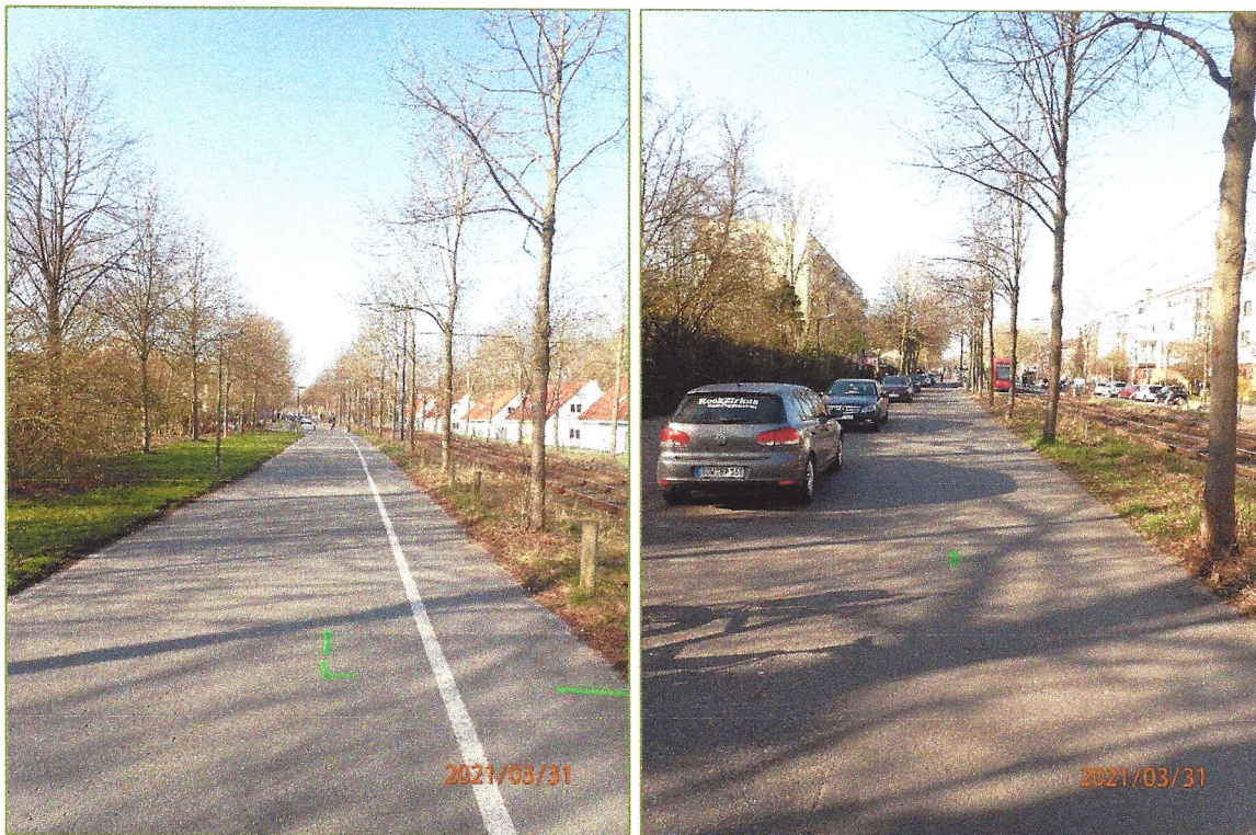
Die grünen Markierungen kennzeichnen die zukünftige Baugrubengrenze
