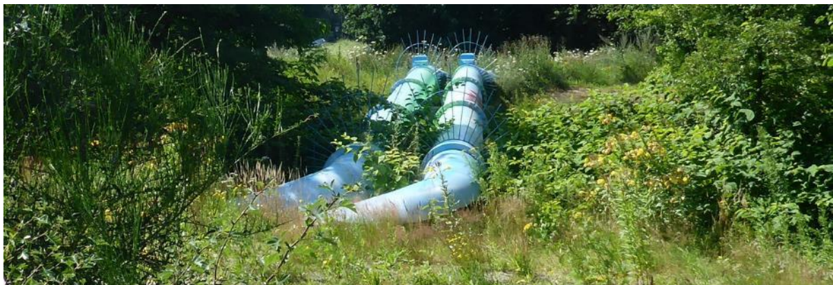
Abbildung 26: Offene Verlegung von Rohren im Bereich des Anbindungspunktes Ecke Hochschulring/Kuhgrabenweg. Quelle: Trassenbefahrung 18.07.2017
